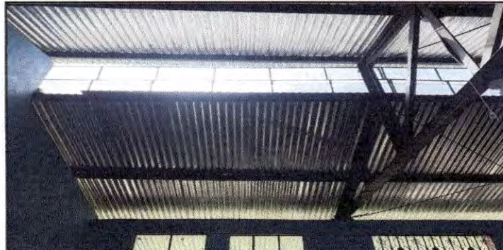
Foto 8: Lámina abollada.
